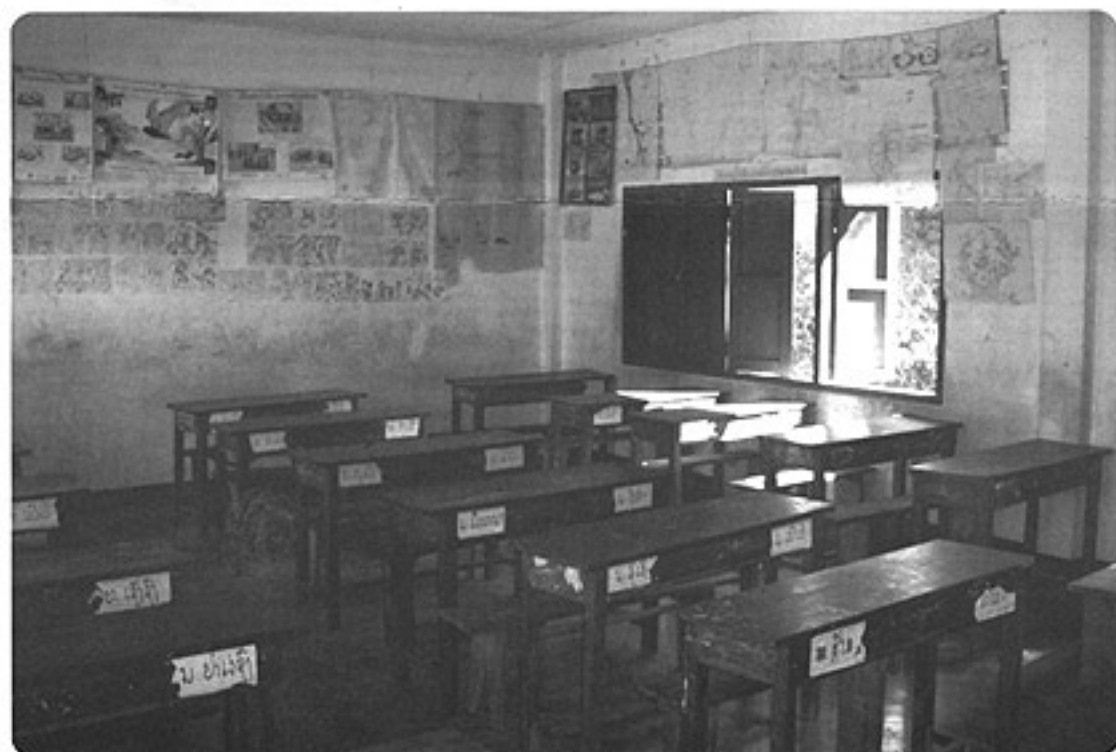
良くメンテナンスされていた教室
