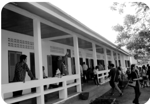
補修されたホアナ村小学校
