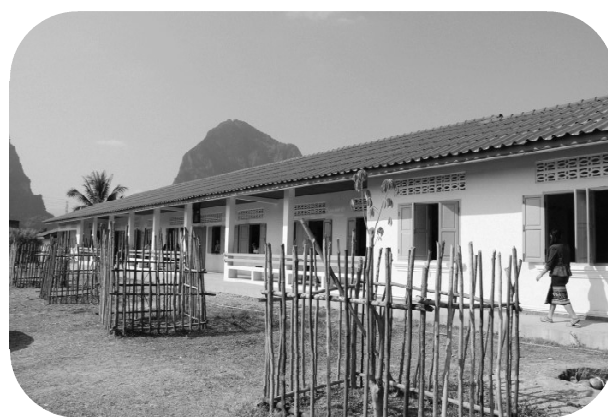
新設のファサン村小学校校舎
