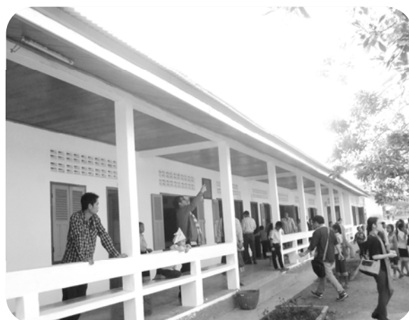
補修されたホアナ村小学校
