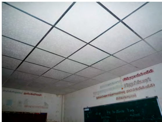
改修工事後の教室天井
