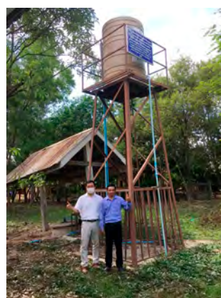
完成した新しい井戸
