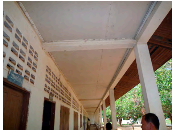
張り替えられたホンガム村小校舎の天井
