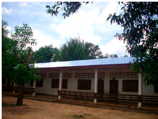
葺き替えられた屋根が輝くホンガム村小校舎
