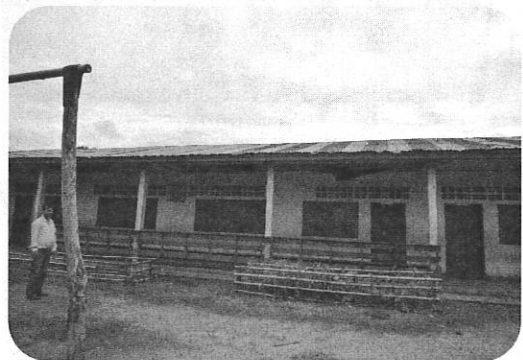
補修前のコンケオ村小学校
