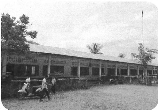
補修後のソムサバット村小学校
