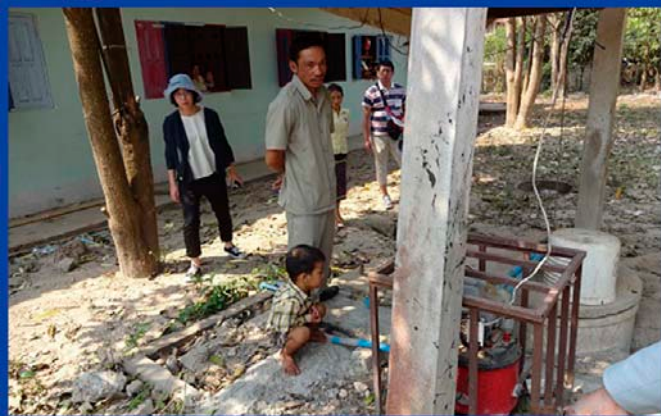
▶ 台風で水没した井戸
