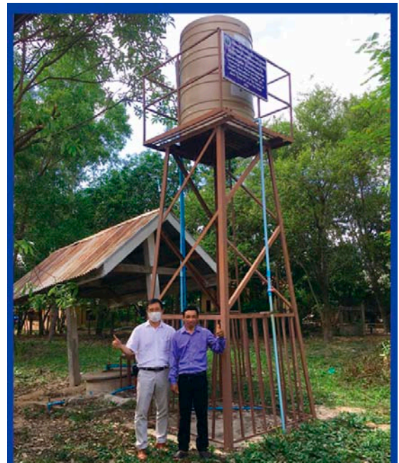
▶ 完成した新しい井戸
