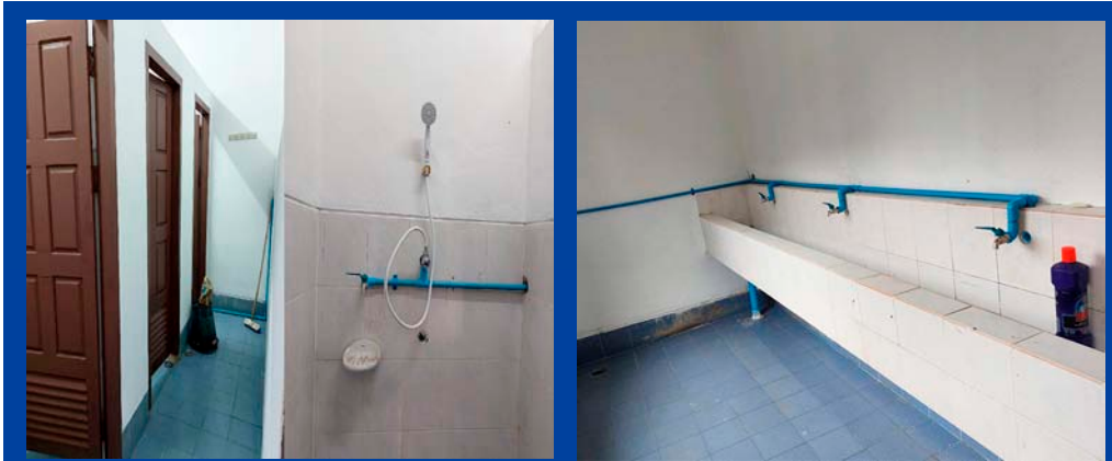
▶ 新設のトイレ、シャワー、洗面所
