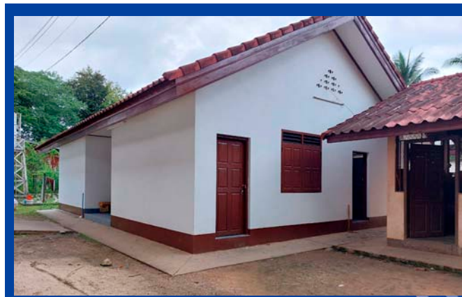
▶ 寮のシャワー・トイレ棟
