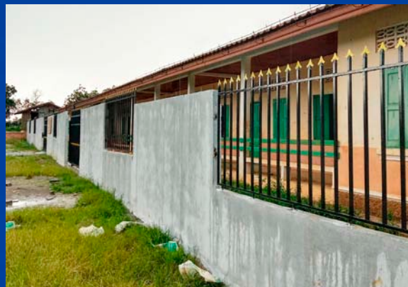
▶ 鉄筋コンクリートのフェンス
