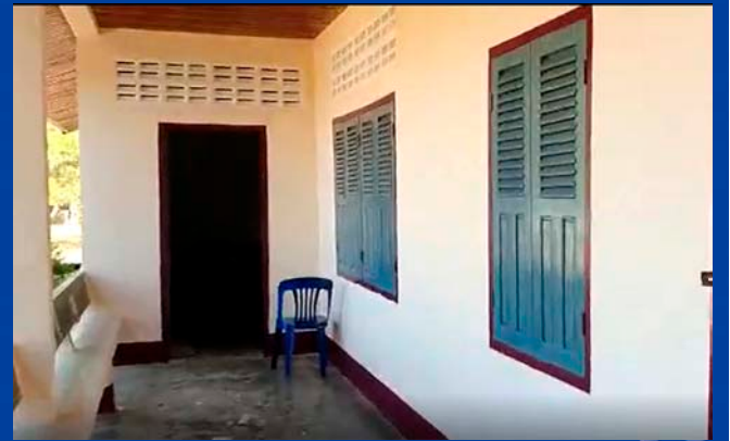
▶ きれいに塗り替えられた校舎
