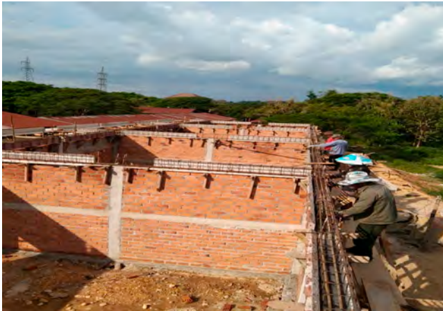
新校舎建設に取り掛かる
